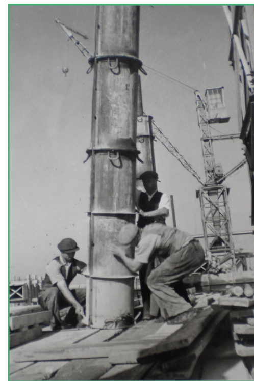
Obr. 4. Stavebné práce v roku 1939. (Zdroj: Vydavateľstvo TEMPO Partizánske.)
